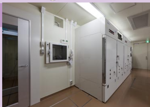
ユニット型ホットセル (2基)
